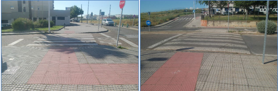
Imagen 127. Rebaje de bordillo en calle secundaria (izq.) y paso sobreelevado en calle prioritaria (dcha.) en la misma intersección
