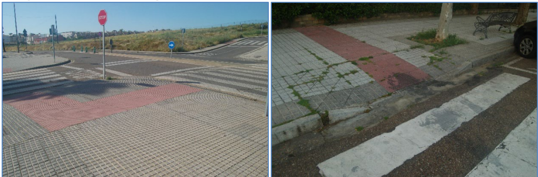
Imagen 128. Pavimento podotáctil de advertencia de ubicación inadecuada
