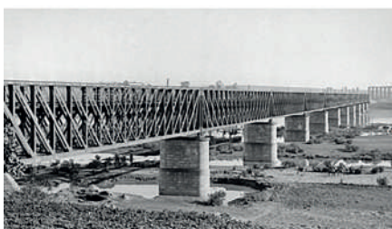
▲ Puente de Hierro sobre el Guadiana.
