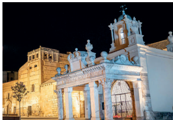
▲ Restauración Hornito de Santa Eulalia
