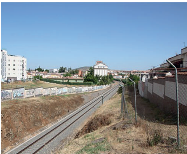
▲ Final del “desmonte de los franceses”.
