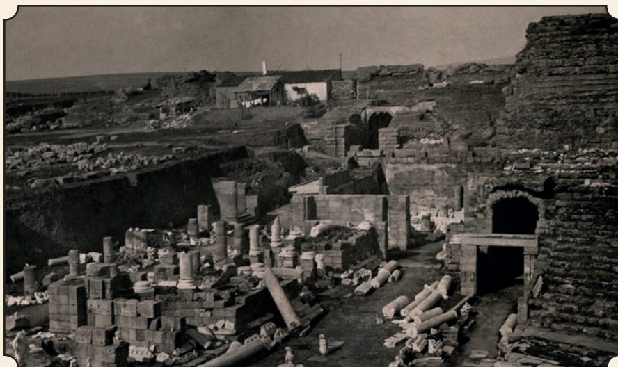
♦ Teatro en fase de excavación. Foto: Boccóni. Cortesía C. Carvajal.
