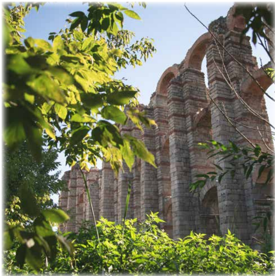
Acueducto de los Milagros
