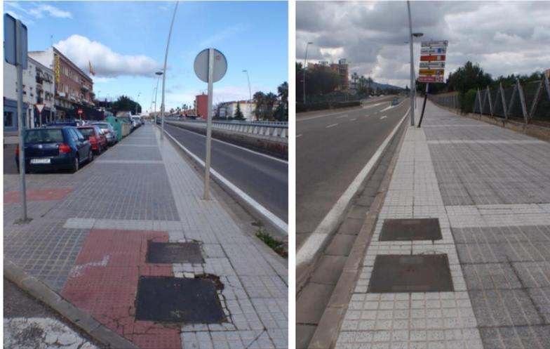
3. Se realiza a continuación un recorrido lineal por canalización de alumbrado reciente, con la instalación de arquetas de bypass en los casos que por necesidad se requiere.
